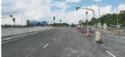
三马拉比第二号新建高规格的智轨列车系统正式启用。
